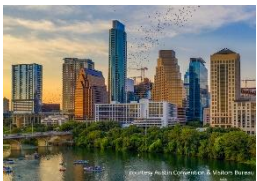
國會大道橋(蝙蝠橋)
